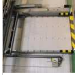
Porte sectionnelle coupe feu EI1 60 / Pare flammes EW60 ACK FORANKRA SAS
